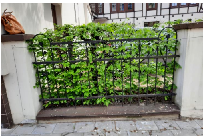
Przęsło metalowe między słupami nr 1 i nr2
