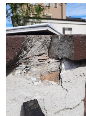
SPĘKANIA , UBYTKI
