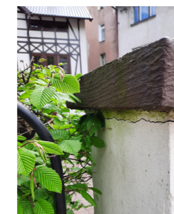
SPĘKANIA , UBYTKI
